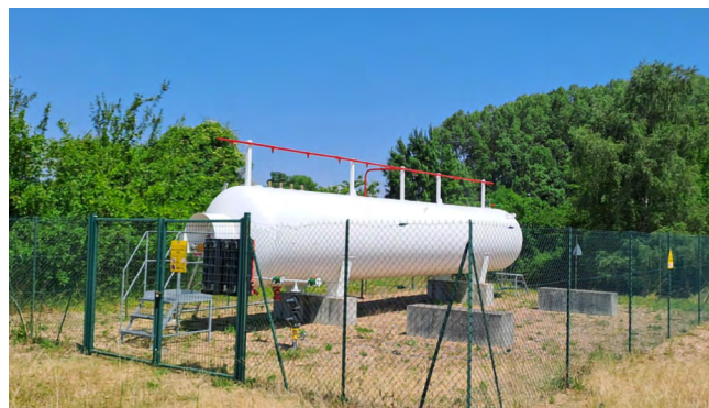
Site de stockage aérien Zone d'Activités Porte de Touraine commune AUTRECHE
