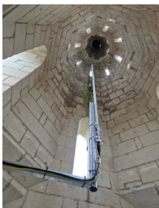
Antenne LoRa posée dans le clocher de la commune de Thizay (CC Chinon Vienne et Loire).
