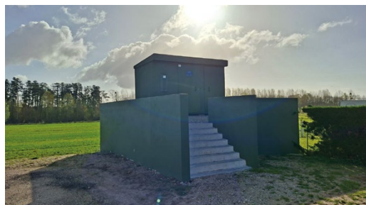
Création d'un poste de transformation à Parçay-sur-Vienne.
