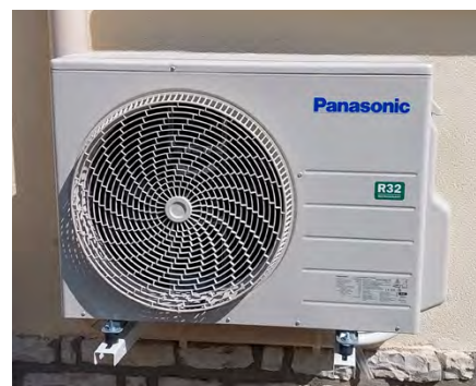
Appel à projet Sobriété énergétique (subvention 2023) : mise en place d'une pompe à chaleur d'émetteurs à la mairie de Marçay.
