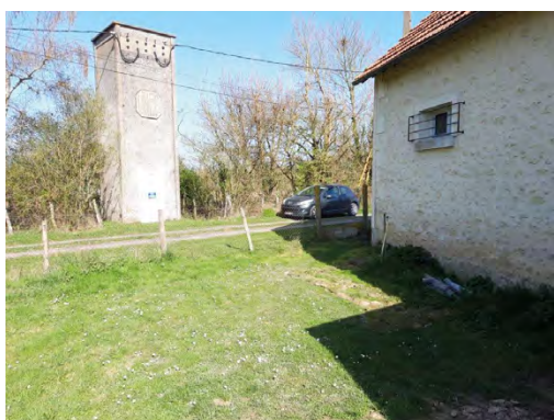
La « cabine haute » au lieu-dit Viaudière, à Nouans-les-Fontaines, a été remplacée par deux postes ruraux compacts simplifiés.
