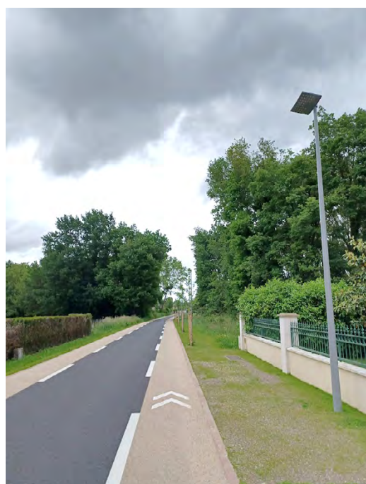
Dissimulation de réseaux aériens électriques aériens à Avoine, dans le secteur du Néman.
