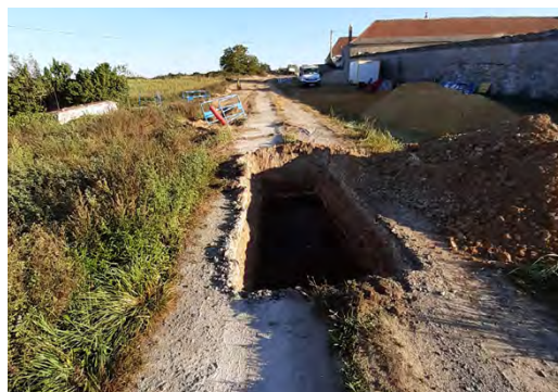
Sécurisation d'un réseau en zone rurale, avec enfouissement, à Monnaie - Les Vallées Puit de forage dirigé.
