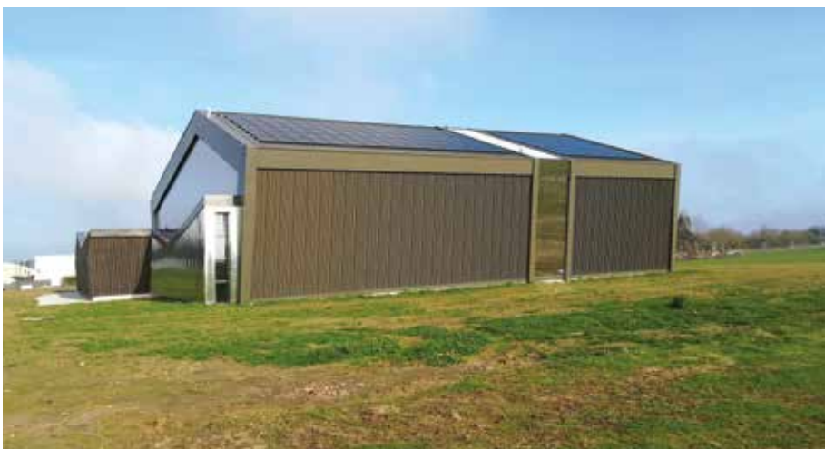
Centrale photovoltaïque en toiture du Gymnase de Saint-Laurent-En-Gâtines (37) (36kWc)
