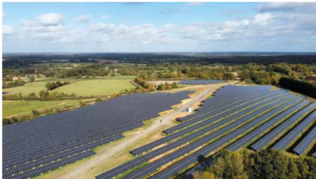
Centrale photovoltaïque de Gournay dans l'Indre (36)
