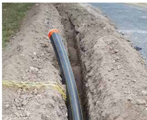
Pose d'une canalisation en PE HD de 160 mm de diamètre pour injection de biométhane
