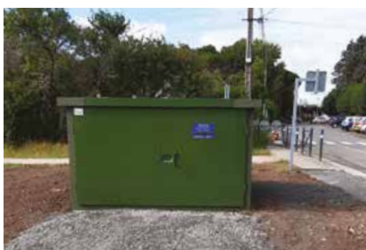
Pose de nouveaux transformateurs
