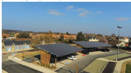
Centrale photovoltaïque en ombrière premium de parking à Saint-Georges-du-Bois (72) (100kWc)
