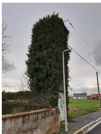
La Tour-Saint-Gelin - Cabine haute à déconstruire
