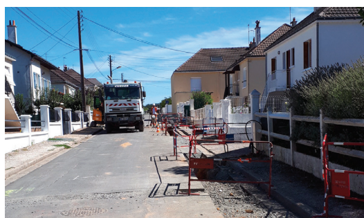
Parçay-Meslay - Réalisation de tranchées techniques communes
