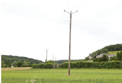
Ligne électrique HTA
