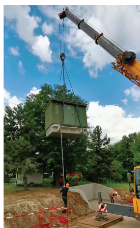
Le Louroux - Mise en place d'un poste de transformation
