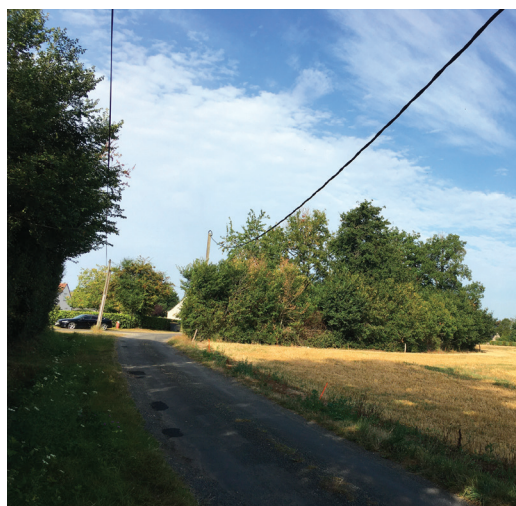
À Vallères, La Chesneraye, le 4 août 2020 : support incliné et ligne trop basse.
