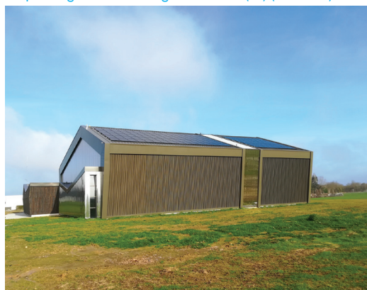
Centrale photovoltaïque en toiture du Gymnase de Saint-Laurent-En-Gâtines (37) (36kWc)
