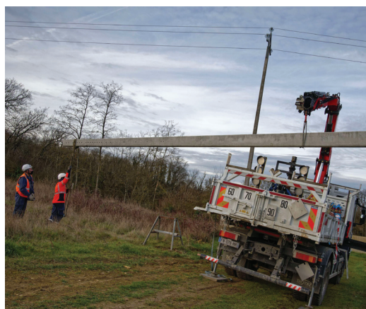
Lussault-sur-Loire - Pose d'un support en béton HTA
