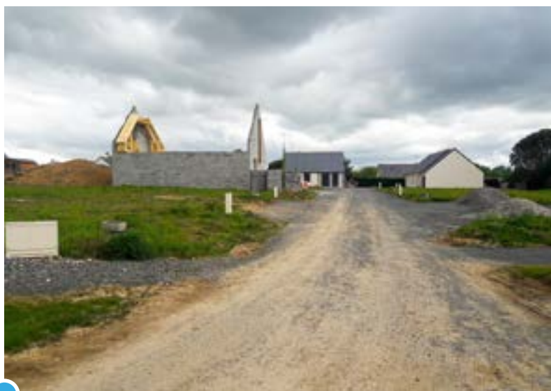
Extension de réseau dans le lotissement de la Croix Saint-Charles, à Thilouze.
