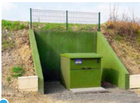
Pose d'un poste de transformation haute tension à Bossay-sur-Claise
