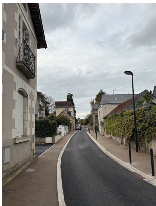
Dissimulation des réseaux aériens à Saint-Cyr-sur-Loire, rue Anatole France.
