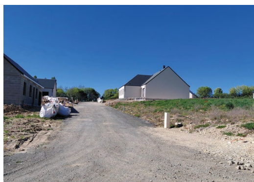
Travaux de raccordement au lotissement Les Jardins d'Éléonore, à Azay-le-Rideau.
