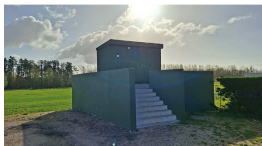
Création d'un poste de transformation à Parçay-sur-Vienne.
