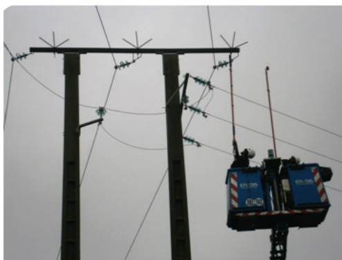
Pose de dispositif de protection des oiseaux avec la LPO en Indre et Loire le 28 novembre
