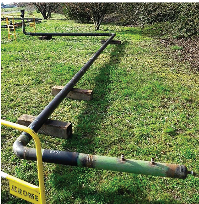
Préparation d'une canalisation acier GRDF
