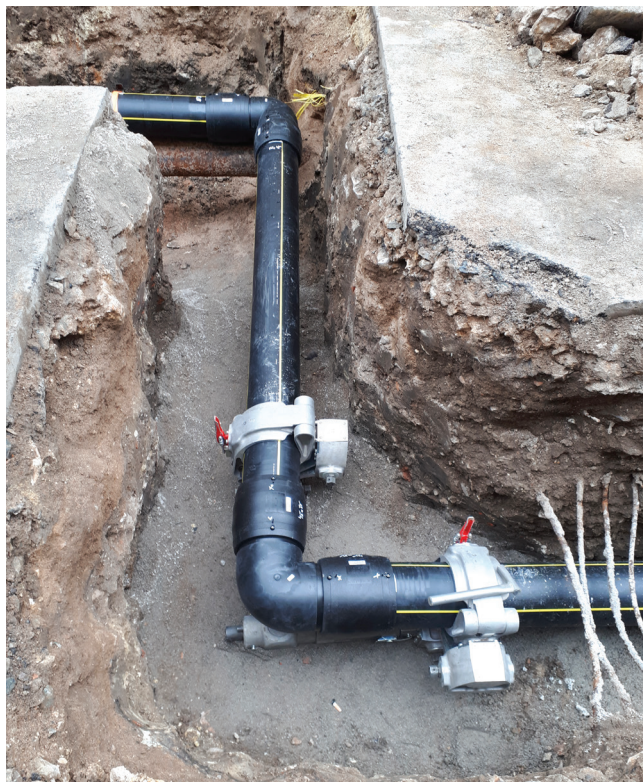
Dévoisement de réseau GRDF
