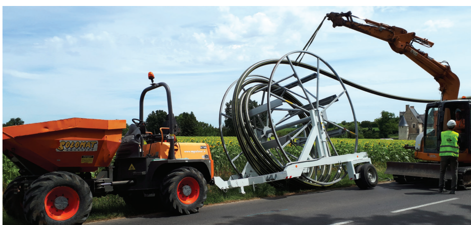
Pose d'un PE 160 mm pour l'injection de biométhane GRDF
