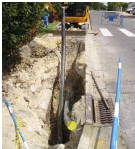
Pose réseau en PE
