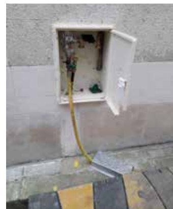
Branchement provisoire Renouvellement réseau sur Amboise
