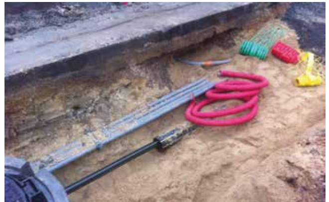
Pose en fourreau d'un PE 63 mm
