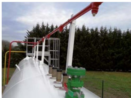
Rampe (en rouge) d'aspersion d'eau pour refroidissement d'un réservoir 22 tonnes en cas d'incendie
