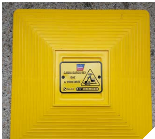
Plaque signalétique réseau gaz
