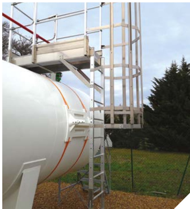
Sécurisation accès sur réservoir 22 tonnes
