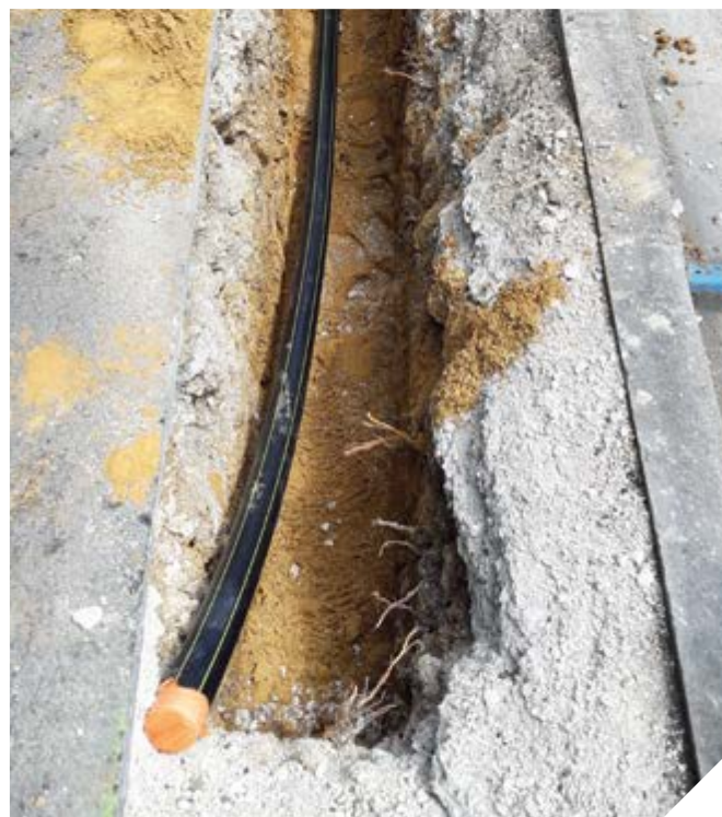
Déroutage d'une canalisation en PE
