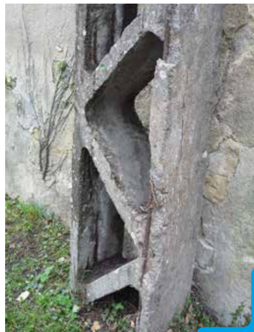
RESTIGNÉ RUE DES CHEVALIERS 20 DÉCEMBRE 2019
