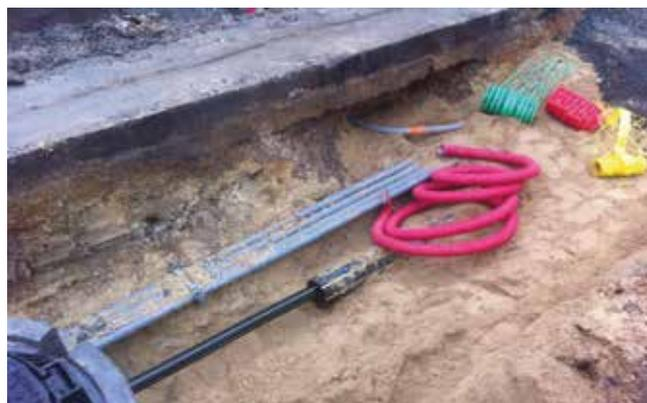
Pose en fourreau d'un PE 63 mm
