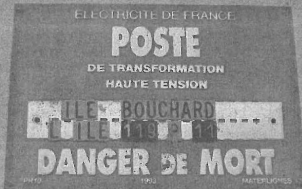
PHOTO 10 10/07/2012 Poste de transformation de L'île BOUCHARD Place Bouchard 37220 L'ILE BOUCHARD
