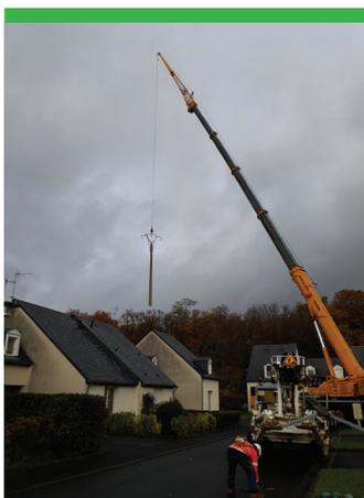
La grue avec une flèche de 65m en action, soulevant un poteau de 13m au-dessus des maisons.
