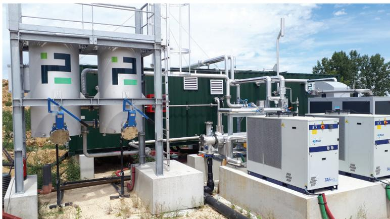
*Unité de filtration et de déshumidification du biométhane avant odorisation et injection réseau*
